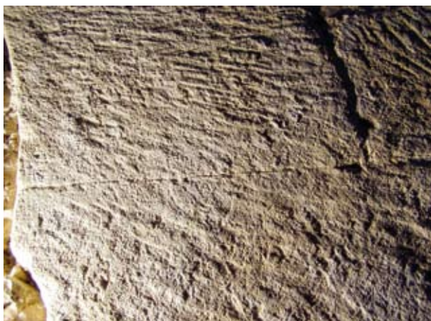
Obr. 5. Plasy, kostel Nanebevzetí Panny Marie. Hřbitovní portál, polovina 12. století, vlasová šířka spáry pískovcových bloků. (Foto Z. Chudárek, 2009)
