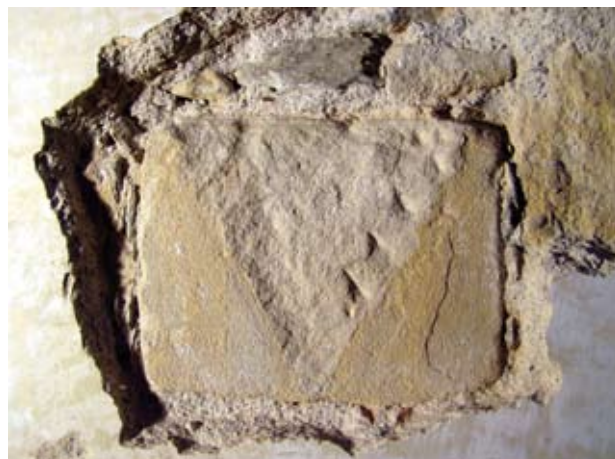
Obr. 15. Plasy, kostel Nanebevzetí Panny Marie. Odsekaná gotická klenební konzola (S3) krácené přípory. (Foto Z. Chudárek, 2009)
