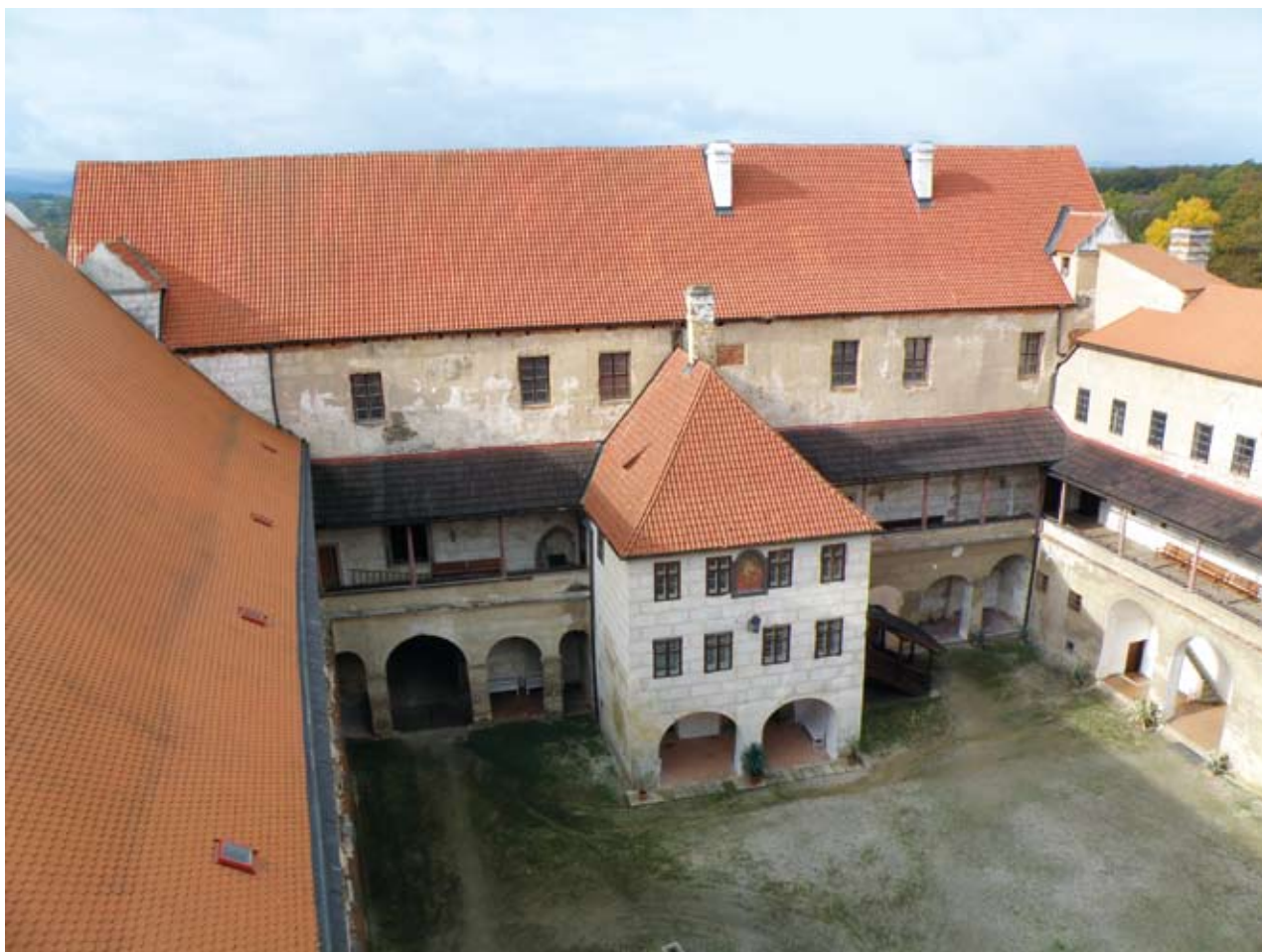
Obr. 4. Horšovský Týn, zámek. Pohled do prvního nádvoří z jihovýchodní věže. Vlevo vidíme obnovenou střechu jižního křídla. Ve středu je západní křídlo, do jehož krovu byl v osmdesátých letech 20. století vložen nedilatovaný ocelový nosník, který vytlačoval oba střešní štíty směrem ven a musel být rozřezán. Vpravo nad ochozem je Lusthaus (západní část) s obnovenou střechou. (Foto M. Solař, 2010)
