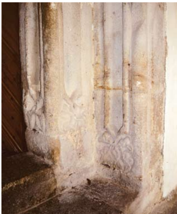
Obr. 7. Srbice, kostel sv. Víta. Kamenická práce na ostění při patě jižního ustupního portálu. (Foto J. Kaigl, 2008)
