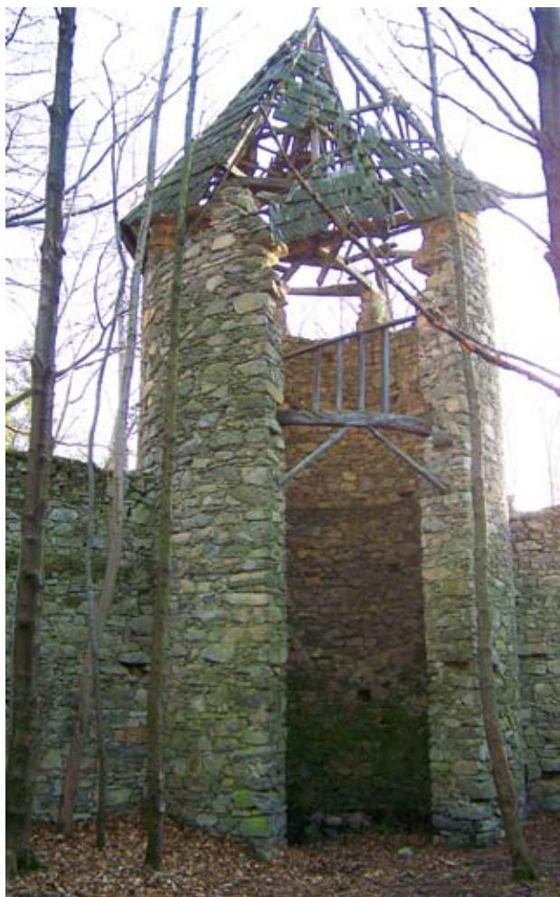
Obr. 5. Prašivice u Nalžovských Hor, hradní zřícenina Ballymote. Vyhlídková bašta s dřevěným zábradlím uzavírajícím její severní stranu, stav konstrukce krovu před zřícením po zimě roku 2011. (Foto M. Rys, 2011)
