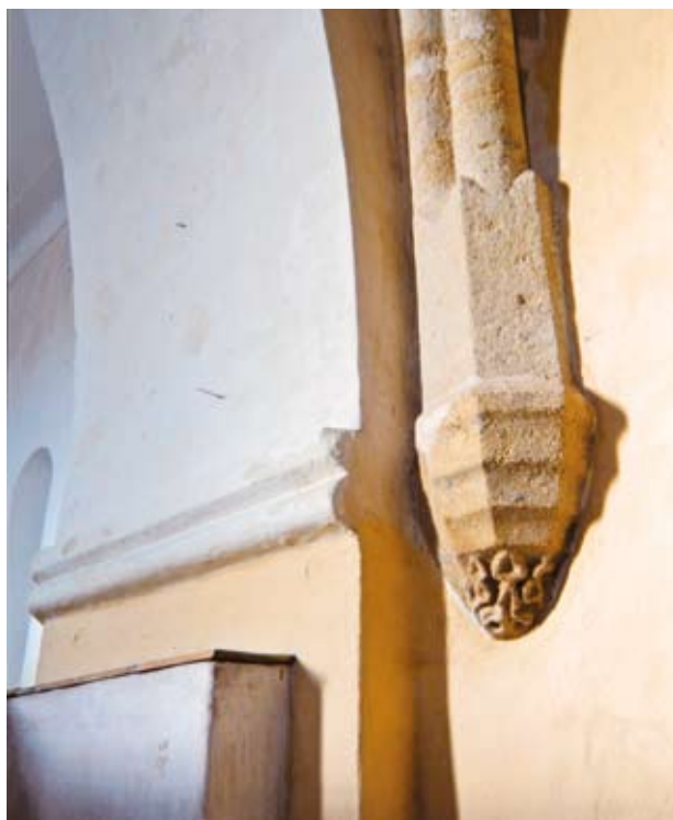
Obr. 8. Srbice, kostel sv. Víta. Severní pata s římsou triumfálního oblouku a klenební konzola v severozápadním koutu chóru. (Foto J. Kaigl, 2008)
