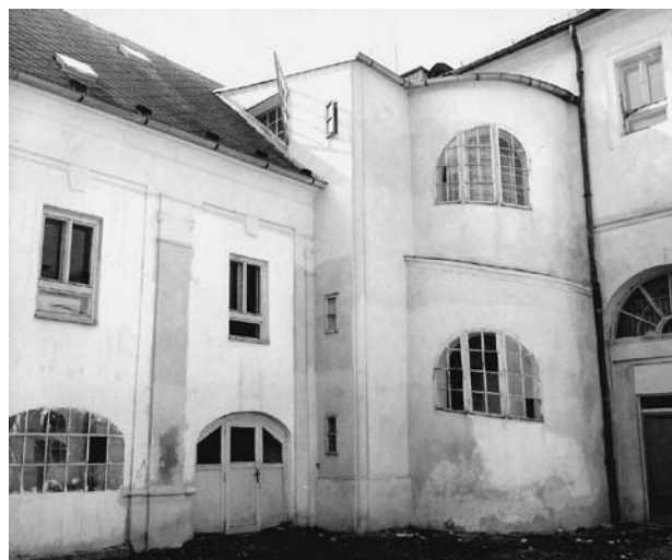
Obr. 5. Kanice, zámek. Kout nádvoří se schodištěm. (Foto J. Gryc, 1990)
