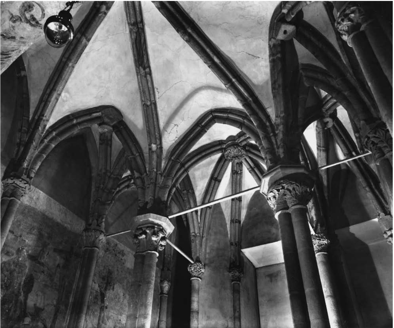
Obr. 14. Horšovský Týn (okr. Domažlice), hrad. Kaple Nejsvětější Trojice v jihozápadní věži, pohled severovýchodním směrem do kleneb. (Fotoarchiv Národního památkového ústavu – ústředního pracoviště, foto A. Patočková, 1949)
