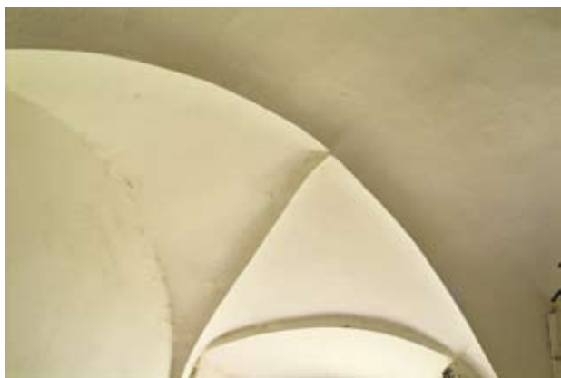
Obr. 15. Nalžovské Hory, zámek. Část renesanční hřebínkové klenby jedné z místností v přízemí. (Foto R. Kodera, 2011)
