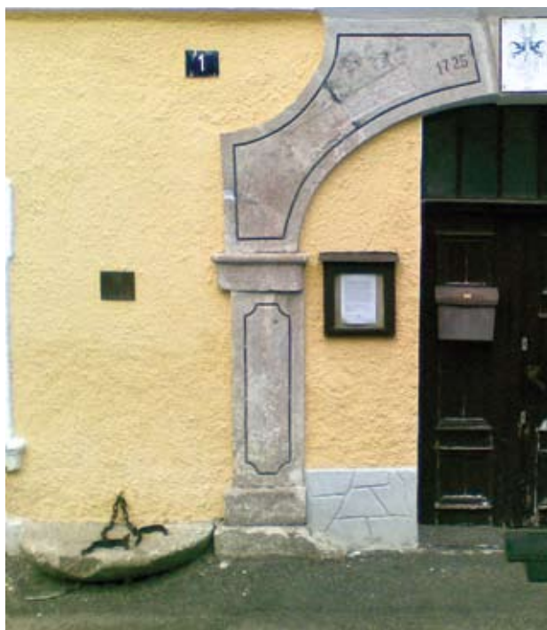
Obr. 4. Mnichov (okr. Cheb), pranýř, tvořený kamenným podstavcem a železnými pouty, u vchodu do radnice. Nemovitá kulturní památka r. č. 25926/4-69. (Foto P. Sokol, 2008)
