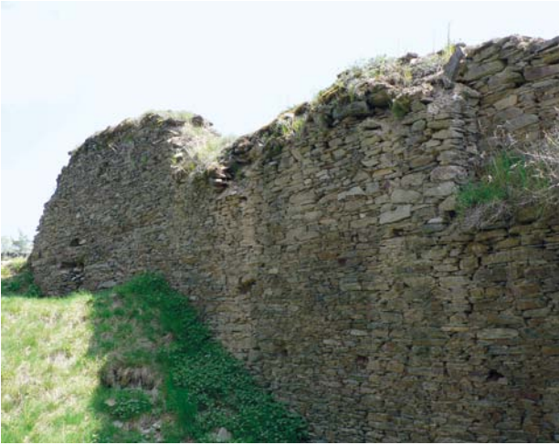
Obr. 20. Okrouhlé Hradiště, zřícenina hradu Gutštejna. Jižní hradba východní části hradu, pohled od západu. Stav před opravou. (Foto T. Karel, 2006)
