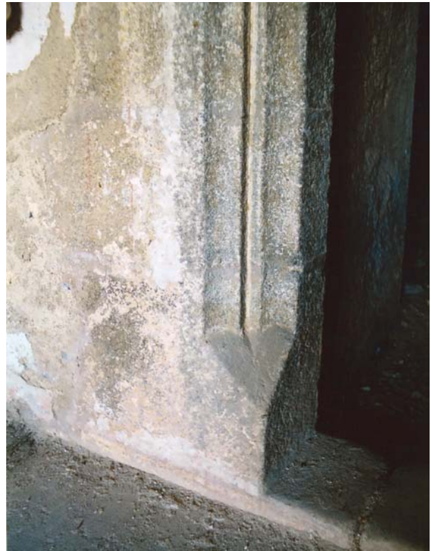
Obr. 2. Racov, kostel sv. Martina. Západní vstupní portál, detail profilace ostění a pata portálu. (Foto J. Kaigl, 2007)
