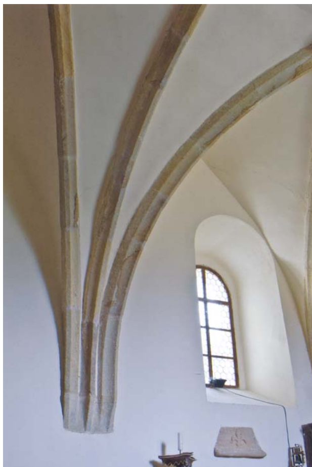
Obr. 12. Vícov (u Přeštic, okr. Plzeň-jih), kostel sv. Ambrože. Pstrojný výběh klenebních žebér na severní stěně presbyteria. (Foto R. Kodera, 2011)
