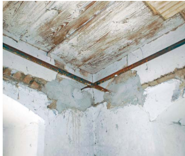
Obr. 17. Kbel, fara čp. 35. Místnost 202, odkrytý starý záklopový strop. (Foto R. Široký, J. Bock, 2011)
