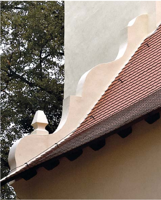
Obr. 8. Bukovec, kostel Nanebevzetí Panny Marie. Styk rubu volutového západního štítu lodi a střešní krytiny. Stav po obnově. (Foto L. Sommer, 2004)
