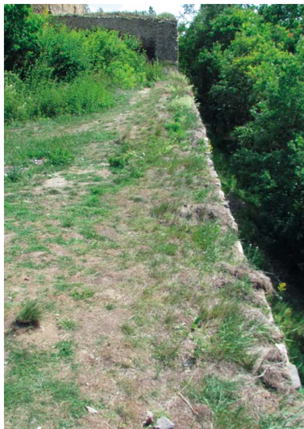
Obr. 19. Okrouhlé Hradiště, zřícenina hradu Gutštejna. Jižní parkánová hradba, pohled na průběh hradby od jihozápadu. Stav po opravě (dozdění parkánové hradby, vyplnění destrukce terénu parkánu, zakrytí koruny hradby). (Foto P. Sokol, 2012)
