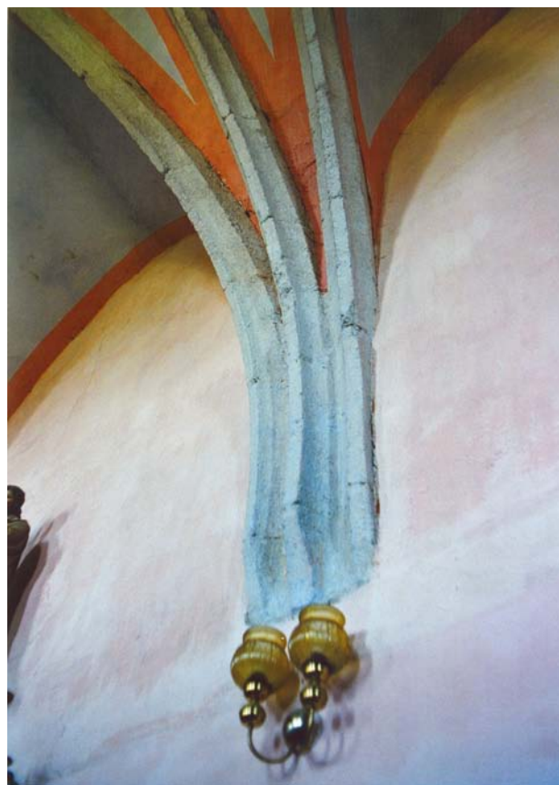
Obr. 6. Meclov, kostel sv. Michaela Archanděla. Potrojný výběh klenebních žebel na severní stěně presbyteria. (Foto J. Kaigl, 2007)
