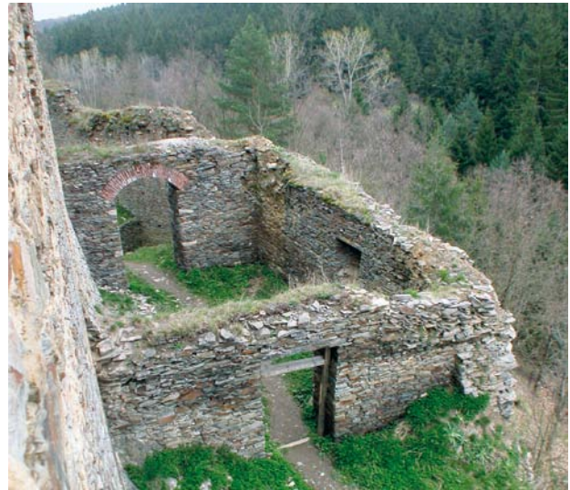
Obr. 16. Okrouhlé Hradiště, zřícenina hradu Gutštejna. Stavění v jižním parkánu, pohled z jižního paláce od severozápadu. Stav před opravou koruny a horních partií zdiva. (Foto P. Sokol, 2006)
