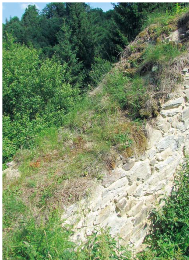
Obr. 25. Okrouhlé Hradiště, zřícenina hradu Gutštejna. Severní hradba východní části hradního jádra, pohled od jihozápadu. Detail zdiva po opravě (dozdění, položení drnového pokryvu). (Foto P. Sokol, 2012)
