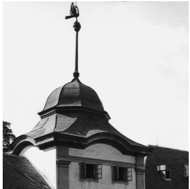
Obr. 5. Manětín (okr. Plzeň-sever), zámek. Střecha jedné z hranolových věží. (Fotoarchiv Národního památkového ústavu, ú. o. p. v Plzni, foto J. Gryc, 1986; výřez)
