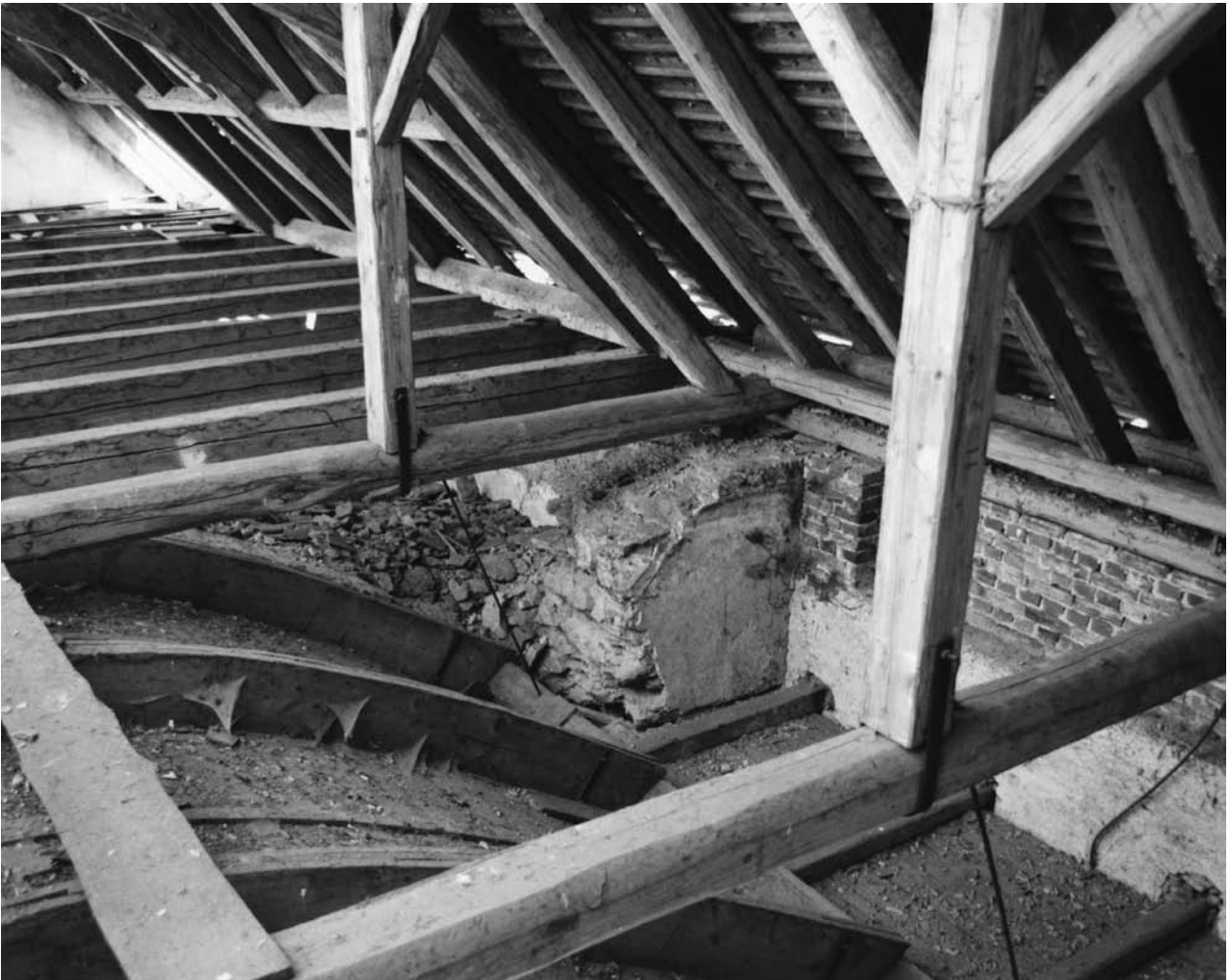
Obr. 15. Miřkov, kostel sv. Víta. Pohled v půdním prostoru nad lodí na torzo západní obvodové zdi při jihozápadním nároží středověké lodí. (Fotoarchiv Národního památkového ústavu, ú. o. p. v Plzni, foto J. Gryc, 1993)
