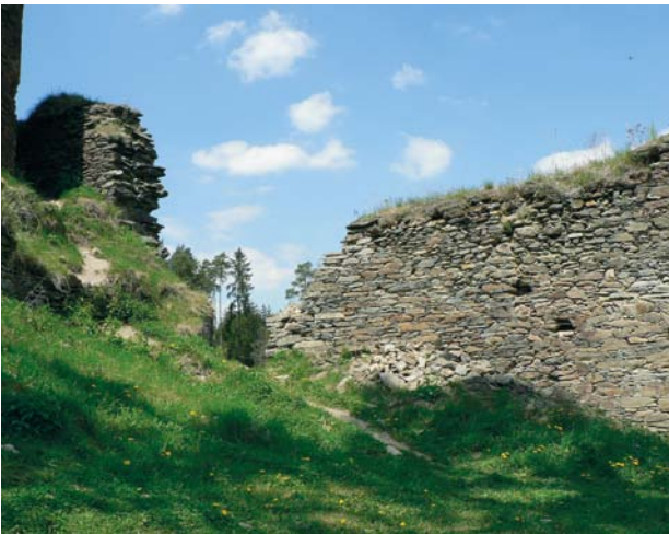
Obr. 22. Okrouhlé Hradiště, zřícenina hradu Gutštejna. Severní hradba východní části hradního jádra, pohled od jihovýchodu. Stav před opravou. (Foto T. Karel, 2006)
