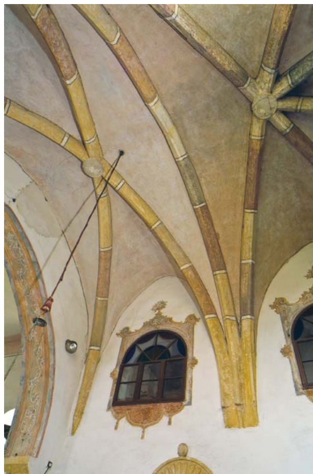
Obr. 9. Blížejov, kostel sv. Martina. Pohled do severozápadní části kleneb v presbyteriu s potrojným výběhem klenebních žebér na rozhraní křížové klenby a klenby paprčité. (Foto R. Kodera, 2011)
