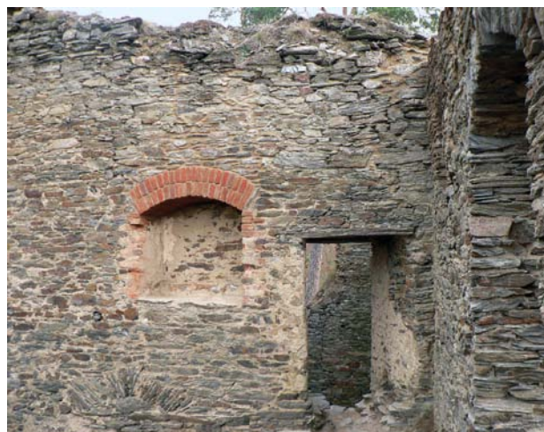
Obr. 8. Okrouhlé Hradiště, zřícenina hradu Gutštejna. Západní část jižního paláce, nika ve východní stěně. Stav po opravě v roce 2009. (Foto L. Havlovic, 2011)
