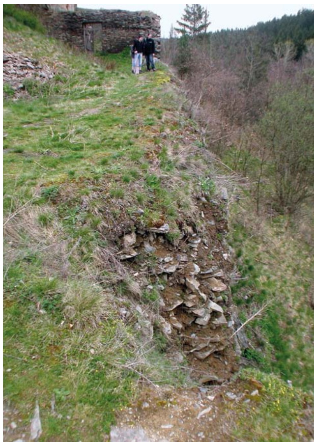
Obr. 18. Okrouhlé Hradiště, zřícenina hradu Gutštejna. Jižní parkánová hradba, pohled na průběh hradby od jihozápadu. Stav před opravou. Vpředu destrukce parkánu způsobená zánikem úseku parkánové hradby. (Foto P. Sokol, 2006)
