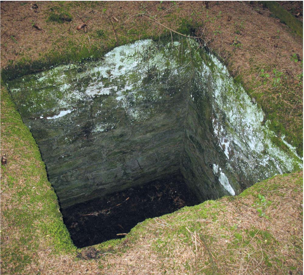
Obr. 12. Crottendorf (Německo, Sasko, Krušnohoří), vlčí jáma z nasucho skládaných kamenů. (Foto J. Hennings, 2011)
