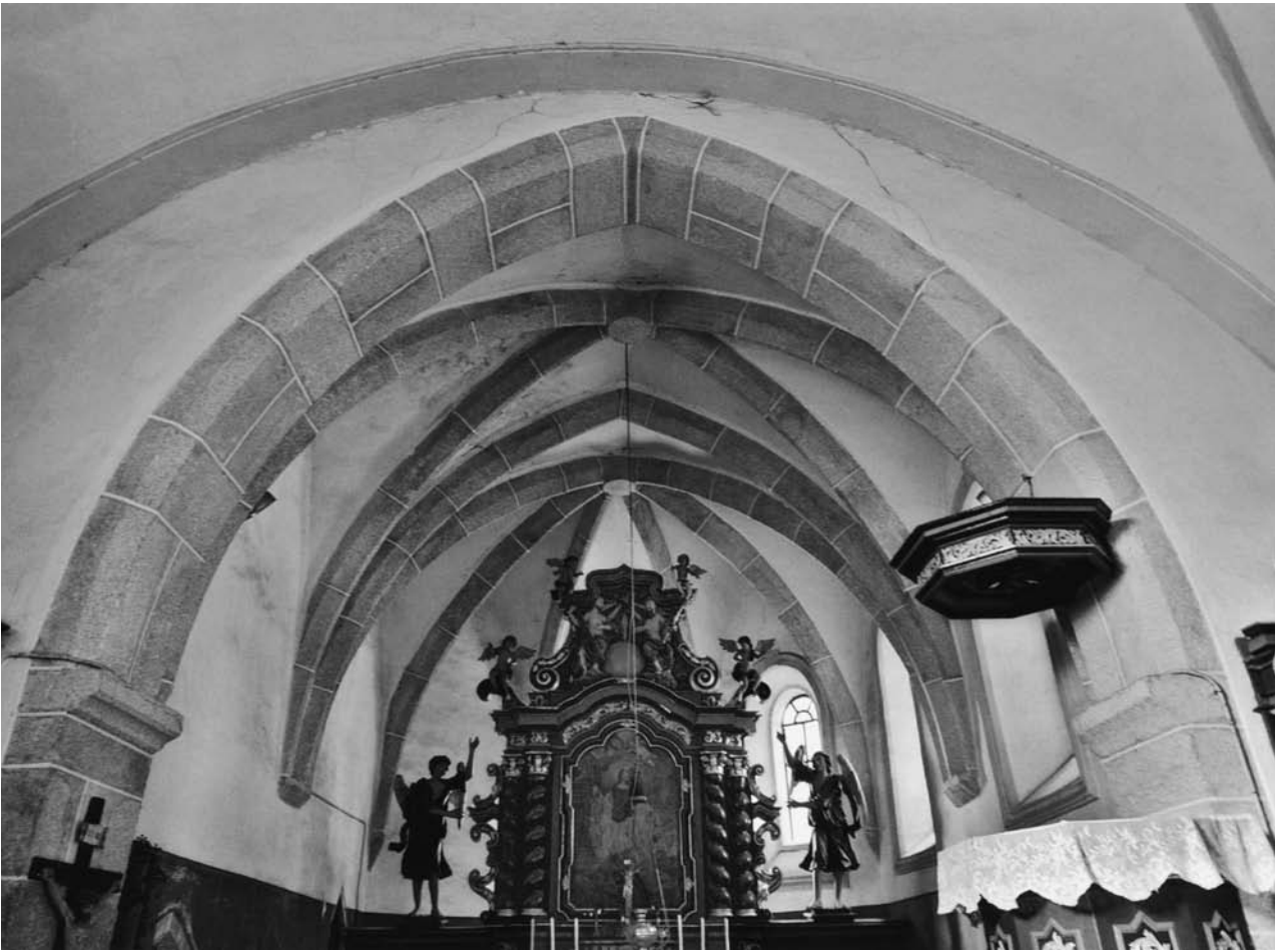
Obr. 17. Mělník, kostel sv. Víta. Pohled do kleneb presbyteria. (Fotoarchiv Národního památkového ústavu, ú. p., foto V. Uher, 1981)
